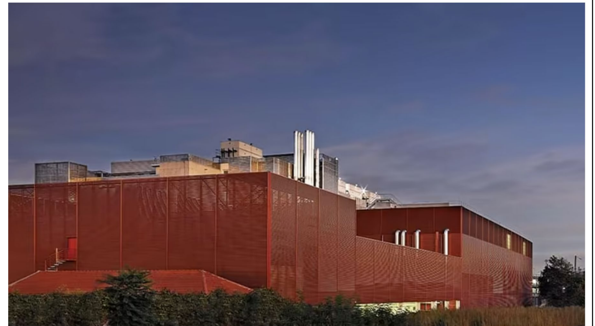
Das betroffene Rechenzentrum in Clichy. Foto: Global Switch
